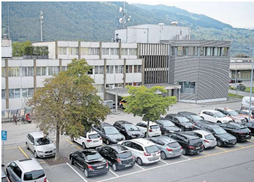
Das Polizeigebäude auf dem Areal Kreuzstrasse.
